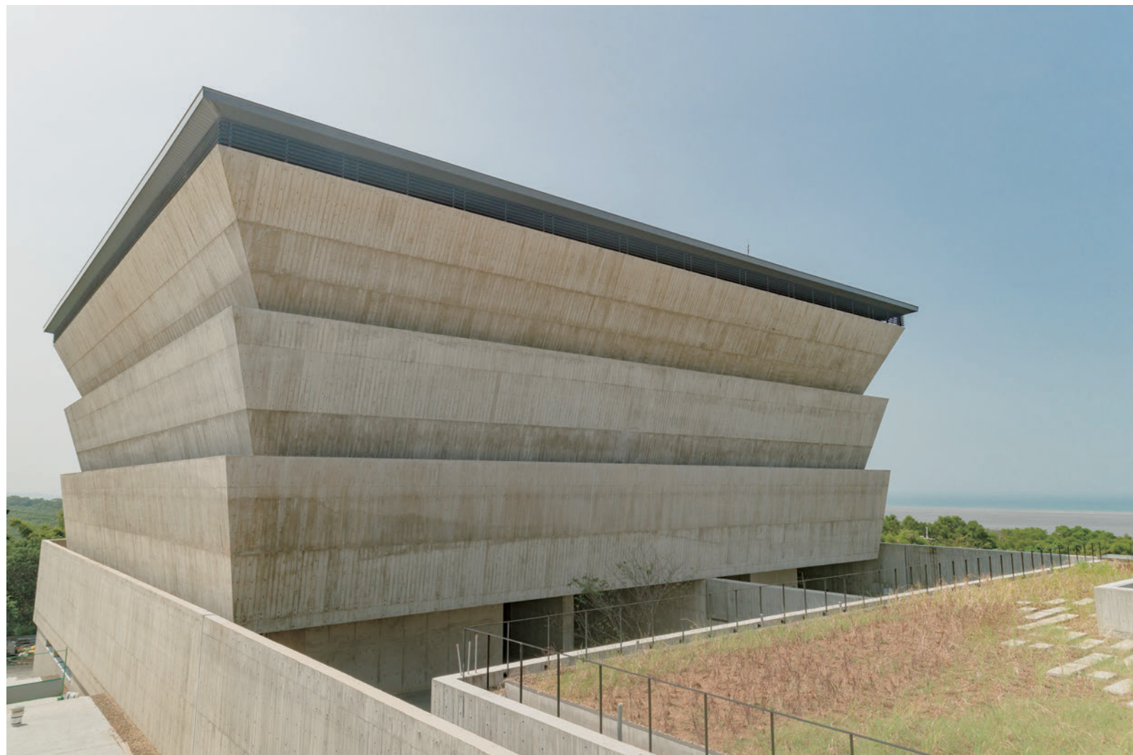
外牆傾斜爭取採光及通風，外觀自然呈現如同花瓣一般層層綻放的美感。
